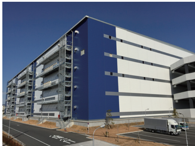
メディアスグループの物流センター（神奈川県相模原市）
